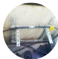
加速光纖 到府建設
